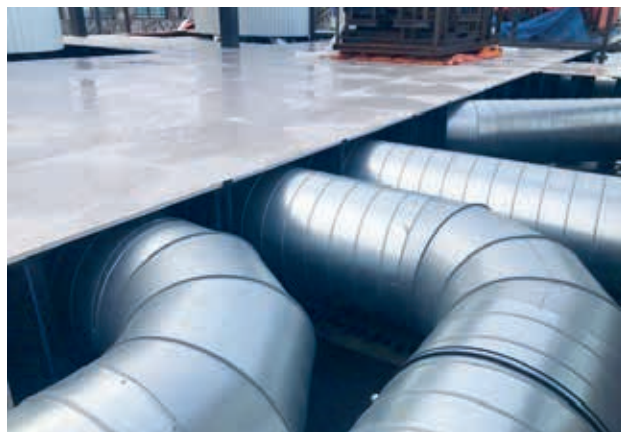
Tegels over de luchtkanalen betekende zorgvuldig kiezen van ondersteuning punten.
