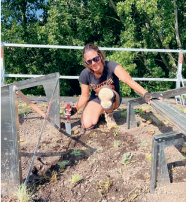
Gedurende de werkzaamheden op het dak stond een tijdelijk hekwerk langs de dakranden.
