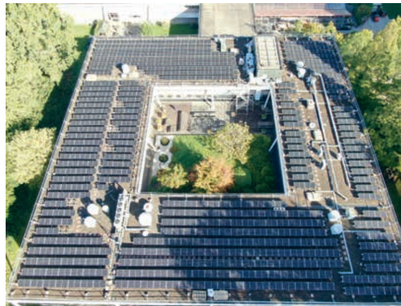
213.000 KWh aan elektriciteit klinkt fors, maar is slechts vijf procent van het jaarlijkse verbruik van het datacentrum.
