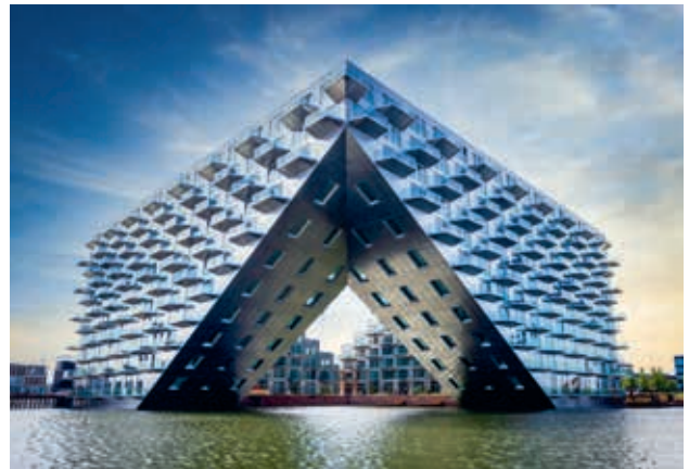
Sluishuis ligt deels boven het water met aanlegsteigers, kunstmatige eilanden, oplopende terrassen en een openbaar toegankelijk dak.
