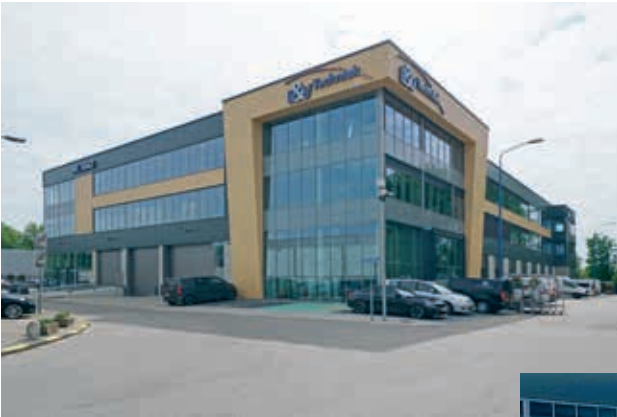
De omvangrijke nieuwbouw van B&V Techniek op Tappersheul in Oudewater.
