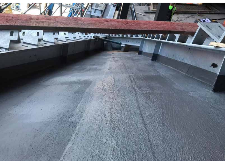
^ Triflexwerk over de brandwerende laag aan de watervalligger
