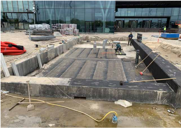
^ Wortelwerende folie aanbrengen
