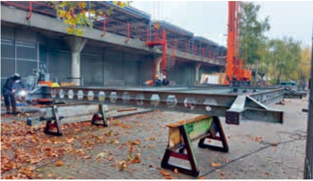
"Er afgetild, op de stoep gelegd, schoongemaakt, aangeheeld en op patio's gezet." (Foto: Team V Architectuur)
