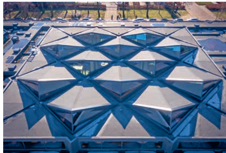
Twaalf lichtkappen in een strak gelid. (Foto: Jannes Linders) Piramides waarvan de top naar voren is gehaald en alleen de twee op noord gerichte vlakken van glas zijn.
