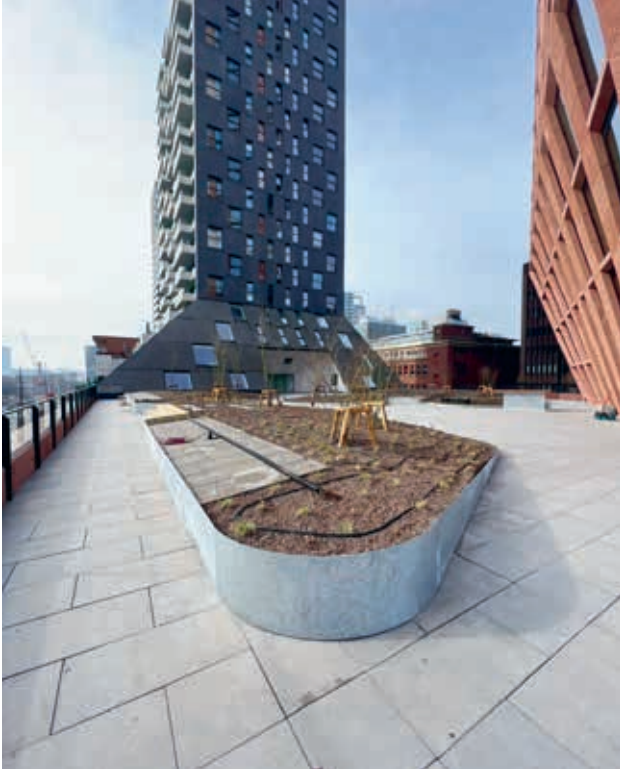
De groenpartijen zijn afgezoomd met verzinkt stalen profielen die op de tegels zijn geplaatst. Op de achtergrond The Muze.
