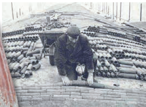
Enkele van de Fusée cylinders die het hart van de ranke constructie vormen. In de wederopbouw zijn meerdere van deze daken gerealiseerd. Architect Bart Kamerling deed een uitgebreide studie naar dit type dak en
