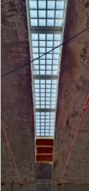
De daklichten zijn in oude staat teruggebracht.
