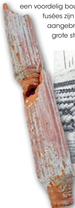
Enkele van de Fusée cylinders die het hart van de ranke constructie vormen. In de wederopbouw zijn meerdere van deze daken gerealiseerd. Architect Bart Kamerling deed een uitgebreide studie naar dit type dak en
