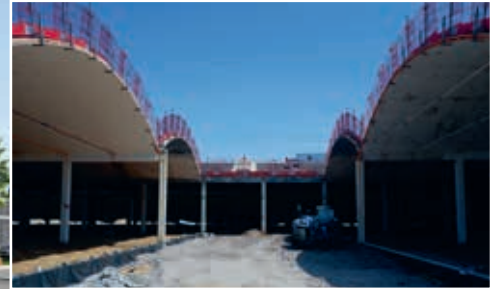
Door drie keer een insnede te maken in drie van de vier bogen ontstaat een bijzondere indeling die ook de brandveiligheid ten goede komt.
