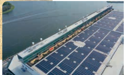
De daktuin is 400 bij 12 meter.
