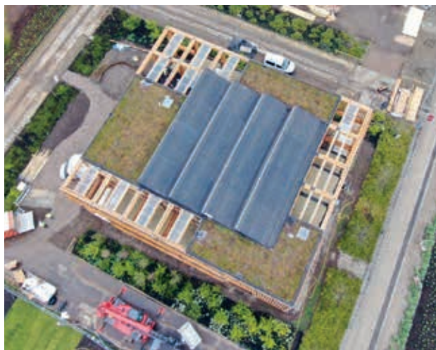
Dronebeeld tijdens de bouw. (Foto: Lambert van den Bosch/Heko Spanten)
