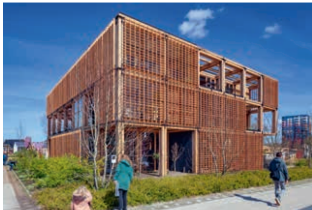
The Natural Pavilion: een mooi voorbeeld dat aantoont dat de klimaatambities van 2050 haalbaar zijn. (Foto's: ScagliolaBrakkee)
