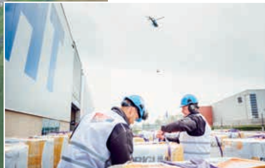
Nauwkeurig afgewogen en ingepakte pallets met rollen worden klaargemaakt voor de hijs naar het dak.
