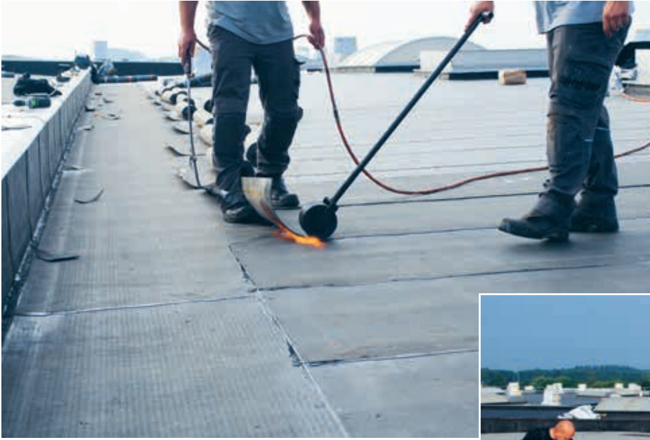
Mechanisch bevestigd, gebrand in de overlap.
