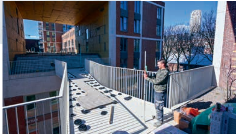
Daktuin met toegangsluiken voor de ondergelegen woningen.
