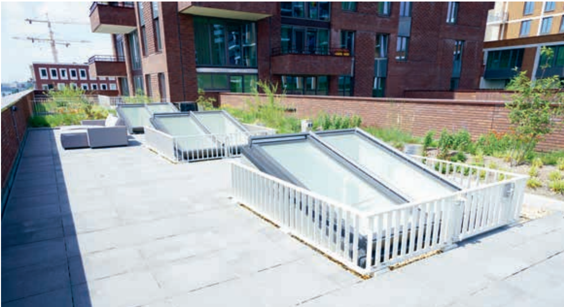
Het betegelen van de loopbruggen was een werk van passen, meten en zagen. (Foto: Michel Klop Fotografie)
