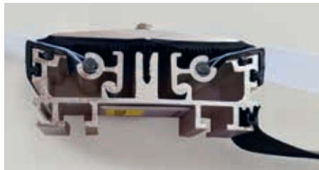
Extrusieprofiel voor de montage van de ETFE-luchtkussens.
