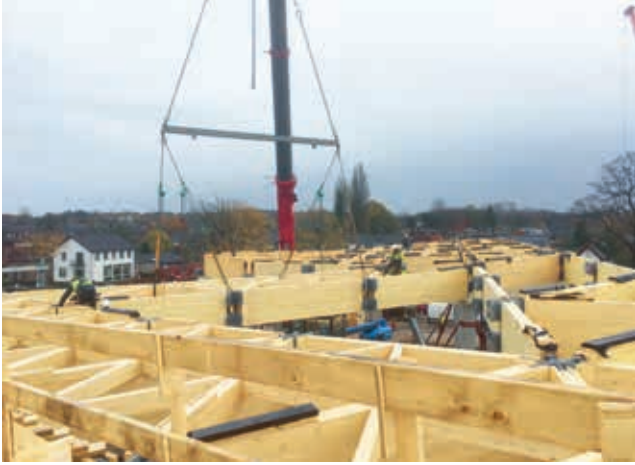
Voor het monteren van de hele kapconstructie was één weekend gereserveerd. (Foto: Hegeman Bouw & Infra)
