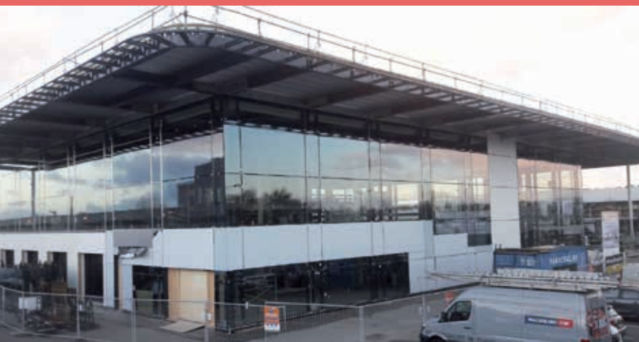
Een 6,5 meter uitkragend dak zorgt ervoor dat het oude en nieuwe één geheel worden.
