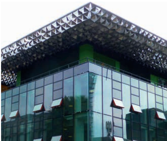
De dakranden van het bladerdak lopen omhoog, waardoor er een elegante en opvallende beëindiging van het dakvlak tot stand is gebracht.
