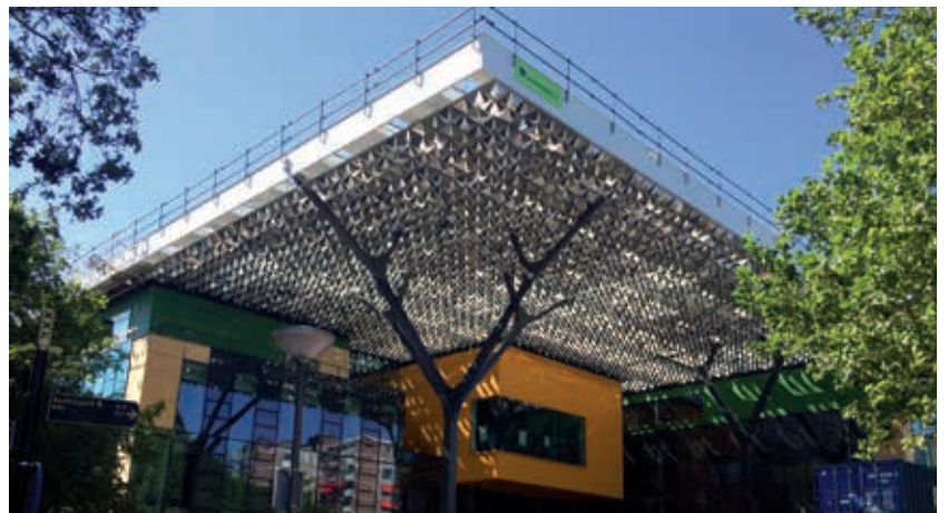
De voorgevel met de entreeuilifel in uitvoering. De lichtdoorval 'verraadt' waar de daklichten zitten. (foto: J.P. van Eesteren)
