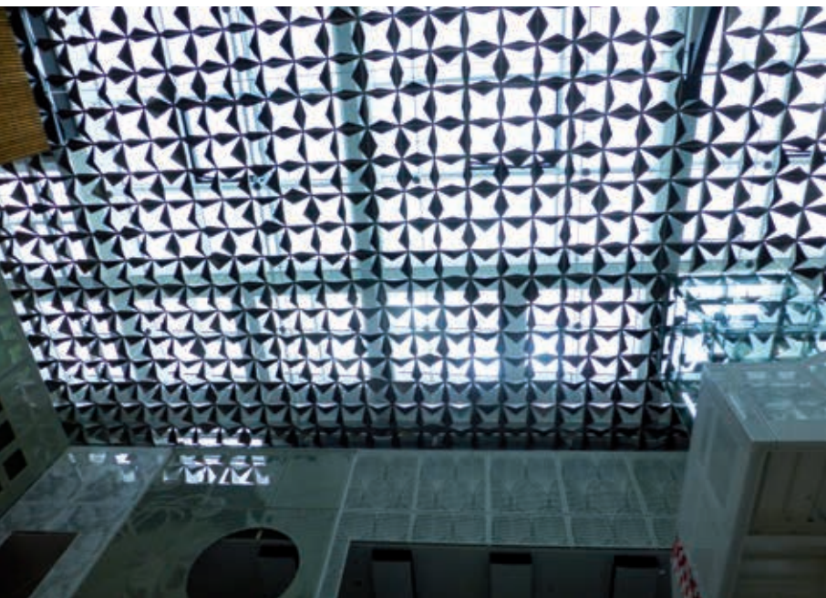
Beeld vanuit het atrium door het bladerdak. Hier is enigszins te zien hoe divers de driehoeken zijn omgezet en wat voor effect dat heeft op de filtering van het daglicht.
