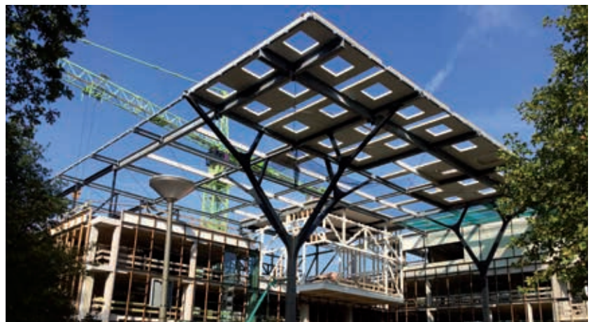
Nogmaals de entreeuilifel in uitvoering, maar nu in een veel eerdere fase. De sparingen in de CLT-platen zijn bedoeld voor de daklichten. (foto: J.P. van Eesteren)
