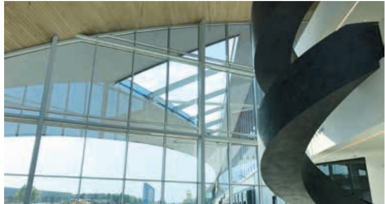
In het atrium is de binnenzijde van de buisvorm afgewerkt met hardhouten lamellen in een onzichtbaar draagsysteem. Door de lamellen horizontaal boven elkaar te positioneren en te draaien kon de kromming van de buisvorm gevolgd worden.
