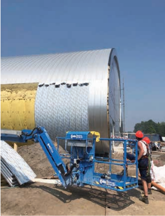
Een deel van de Kalzip is vanaf hoogwerkers gemonteerd, een deel vanaf steigers en een deel vanaf de buis-in-opbouw.
