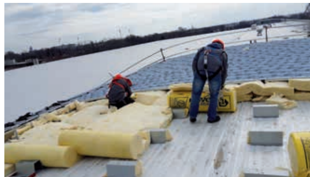
Om veilig te werken op de buisvorm gebruikten de bouwers harnassen met lifelines en valbeveiliging op de dakranden.
