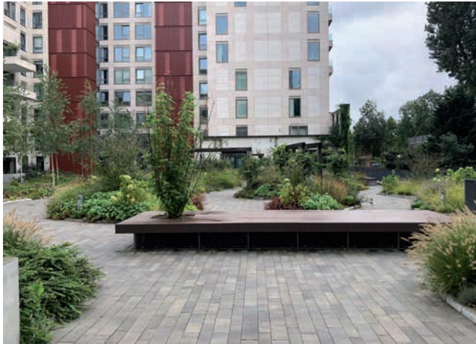
De ventilatiegaten van de parkeergarage zijn in de grote banken verwerkt. Onder de banken zijn daartoe roosters geplaatst.
