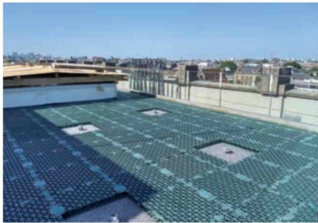
De opbouw met de 65 mm hoge retentie-elementen RSX 65.
