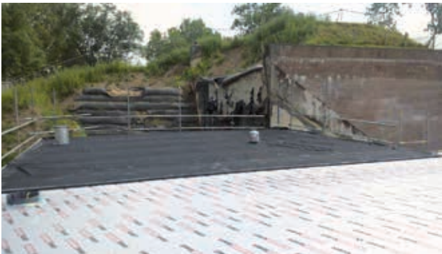
De HERTALAN® Easy Weld EPDM dakbedekking is in zo groot mogelijke membranen aangevoerd en verwerkt. Daaronder ligt de 120 mm dikke PIR schuim isolatielaag (Foto: Bitasco)
