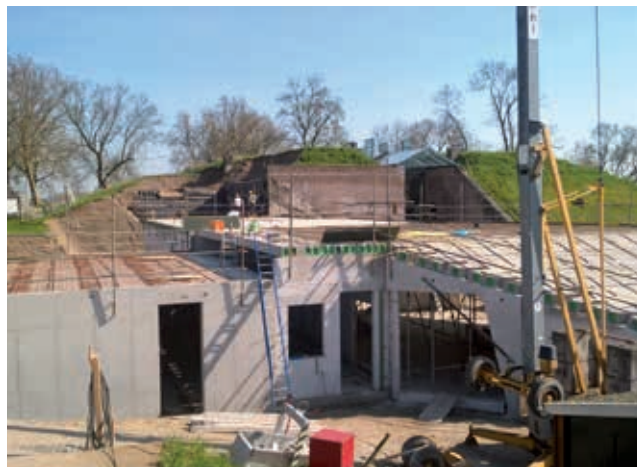
Links op de foto het lagere dak boven de keuken; rechts het hellende vlak van het hoofddak, dat naar achteren toe doorloopt tot aan de metselwerkwand (Foto: Bitasco)
