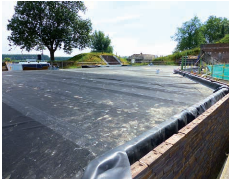
De onderconstructie van het hoofddak is klaar voor de EPS blokken en de verdere afwerking met worteldoek, grond en gras
