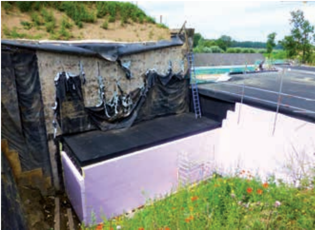
Achter de bebouwing onder het hoofddak ligt nog een klein, lager bouwdeel met een plat dak; hier zijn breedplaat vloeren gebruikt
