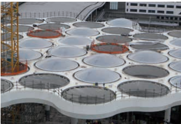
Het aanbrengen van de luchtkussens in de 49 sparingen is in volle gang (foto: Buitink Technology).
