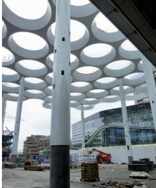
Eén kolom in detail. Het donkere deel is de betonnen "voet" die vanuit de fietsenstalling door de pleinvloer steekt. Daarboven de stalen buiskolom die doorloopt naar de overkapping.
