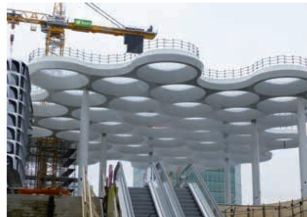
Beeld van de overkapping vanaf straatniveau. Het plein is onder andere via roltrappen te bereiken.
