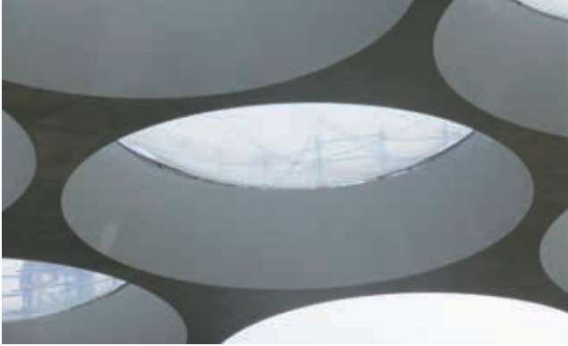
Aan de onderzijde van de luchtkussens zijn dunne staalkabels aangebracht om de folie te verstevigen bij extreme belastingen.
