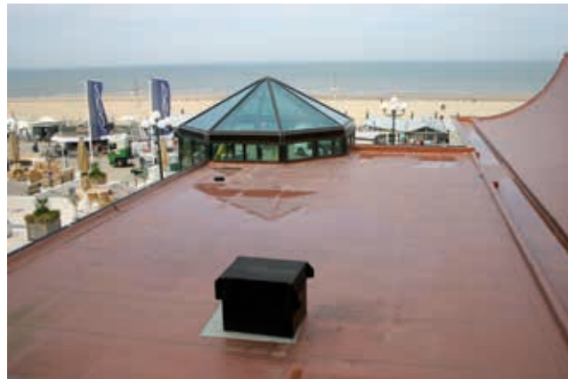
Een vlak dak in de randzone met aansluiting op een hoektorentje. Dit dakdeel komt aan de weerszijden van de entreegang (tussen de vlaggen) voor.
