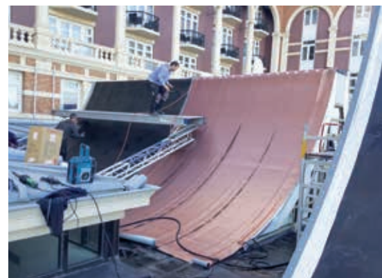
Voor het uitrollen en aandrukken van de dakbanen op de schaaldaken was een speciale constructie ontwikkeld.
