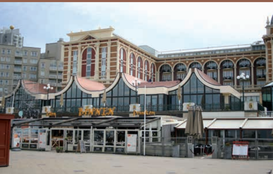
Een deel van de gevel van het Kurhaus aan de strand/boulevardzijde met de kenmerkende schaaldaken, waarop nieuwe dakbedekking is aangebracht.
