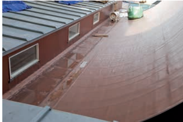
Nogmaals de aansluiting op het roevendak maar nu op een andere zijde, waarbij in het opgaande werk, kozijntjes moesten worden ingewerkt.
