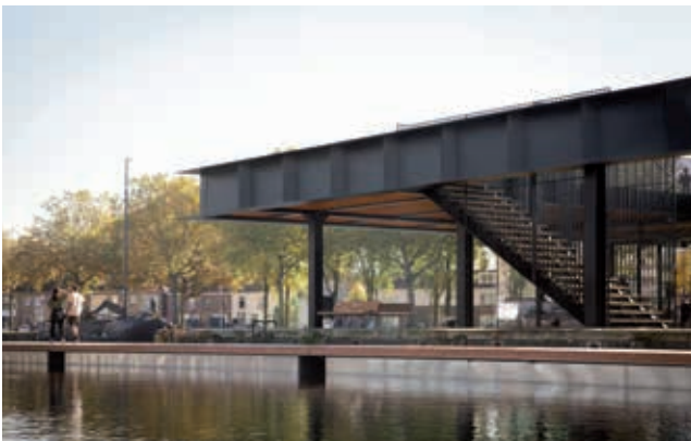
Het plateau is te bereiken via een open stalen trap. Op deze foto zijn ook de driehoekige vinnen in de dakrandconstructie goed te zien.
