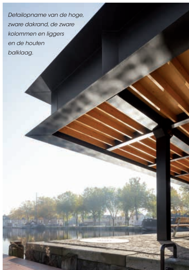
Het plateau is te bereiken via een open stalen trap. Op deze foto zijn ook de driehoekige vinnen in de dakrandconstructie goed te zien.
