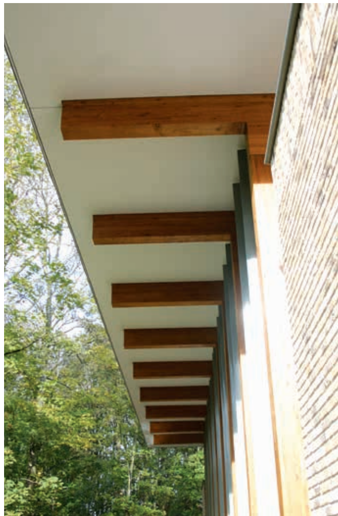
De larikshouten spanten van de aula zetten zich voort aan de buitenkant.
