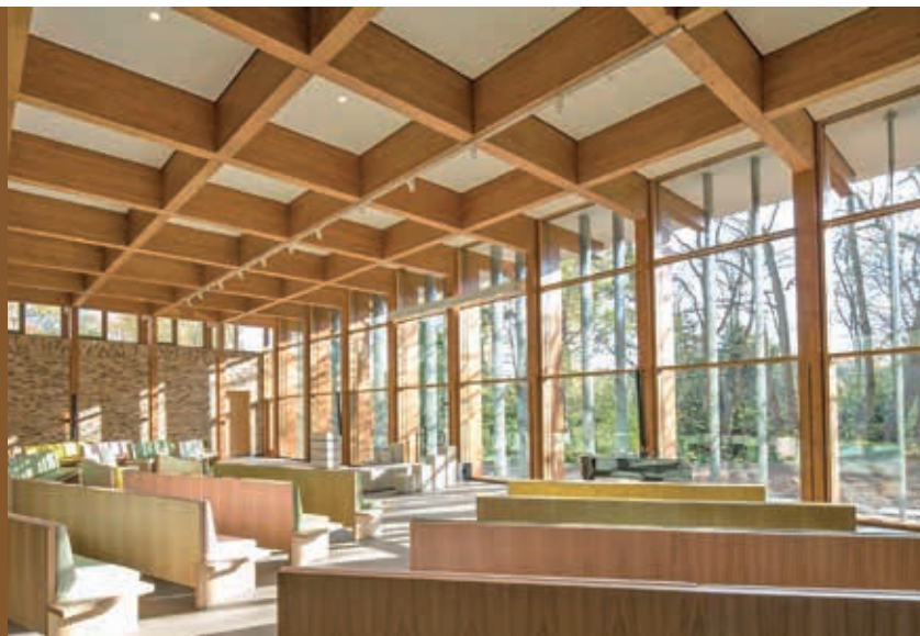
De onderconstructie van het dak van de aula bestaat uit gelamineerde larikshouten spanten en geprefabriceerde dakdozen in een strak ritme.
