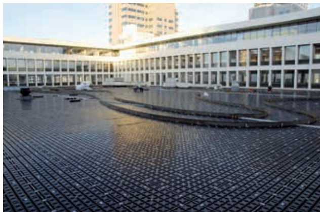
De eerste verdieping van het kantoor sluit aan op de tuin, die een beter uitzicht biedt dan de grindbak die er eerst op het dak lag.
