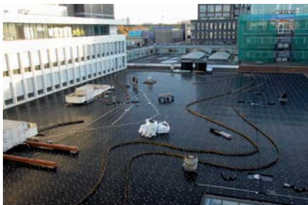
De kratten van het polderdak zijn geplaatst en daarop zijn al enige slingers van cortenstaal aangebracht als scheidslijnen tussen paden en plantenvakken.
