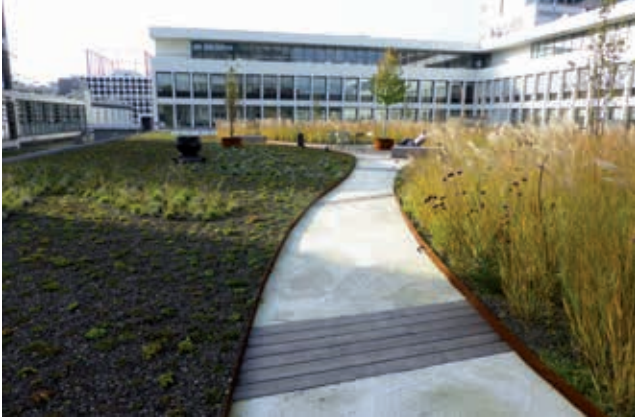
De looppaden bestaan grotendeels uit in het werk gestorte banen beton, hier en daar onderbroken door bamboevlonders.
