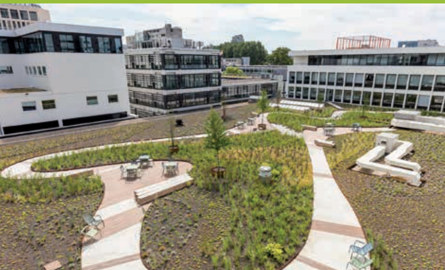
Het parkdak met rondlopende, gebogen wandelpaden, 'pleintjes' met meubilair en een wisselende beplanting nodigt uit tot gebruik.
