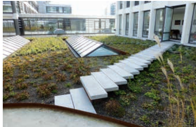
Het parkdak is vanuit verschillende toegangen te betreden, o.a. via een vernuftig aangelegd pad van betonplaten.
