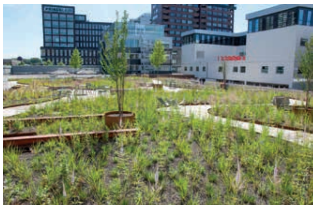
Rond de zeven bomen zijn hogere ringen van cortenstaal geplaatst, die volledig gevuld zijn met substraat om ze meer 'grond' te geven.
