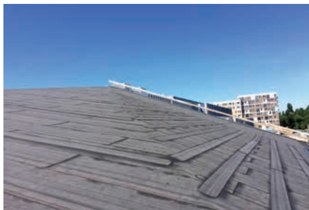
Dak 3a maar dan het sterk hellende stuk is qua dakbedekking klaar. Nu nog de opbouw van het groendak.
