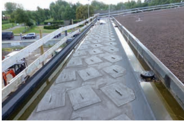
Eén van de dubbele gootstroken langs de randen van dak 3b. De rechtere goot heeft pluvia's en is de hoofdgoet van het groendak. De linkergoot is een overloopgoet onder de doorlopende gevelbeplating. Op de verhoging middenin zijn de ankerstrips ingewerkt, waarop de aluminium constructie van de gevelbeplating wordt gemonteerd.
