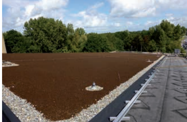
Foto van dak 3a genomen vanuit de meest zuidelijke hoek bij de aansluiting met dak 2. Het substraat is aangebracht, maar moet nog worden ingezaaid.
