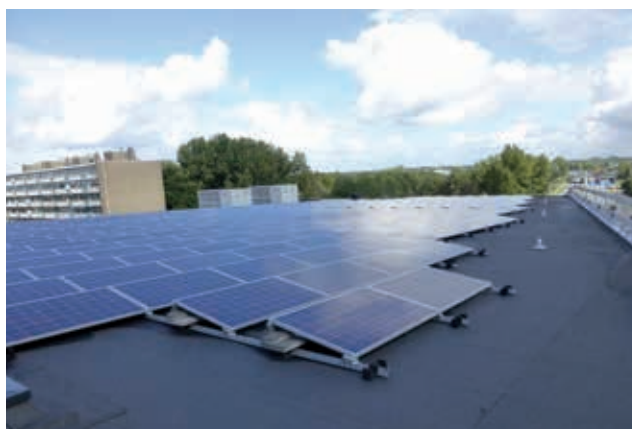
Dak 2 is geen groendak geworden, maar een dak met zonnepanelen. Het is licht hellend.
