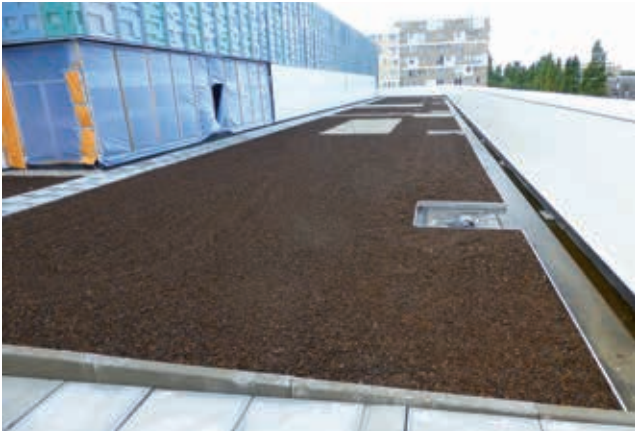
Het substraat van het groendak van dak 5 is aangebracht en moet nog worden ingezaaid. Rechts langs de borstwering loopt de goot; de pluvia's liggen iets terug in het dakvlak.
