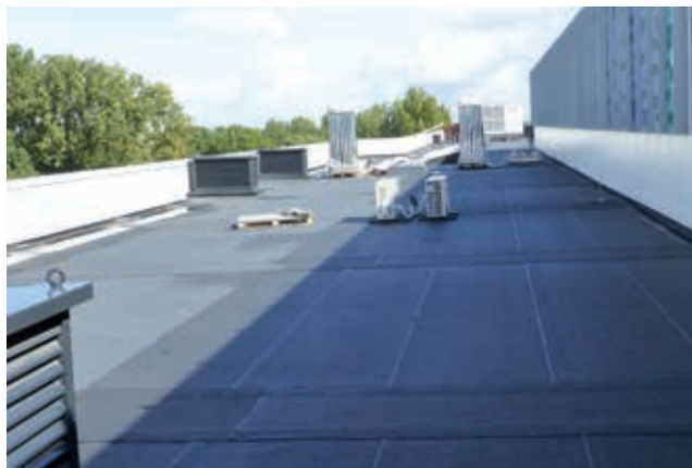
Dak 4, het installatiedak, heeft een 'naakt' aanzien: geen ballastlaag en geen groendak.
