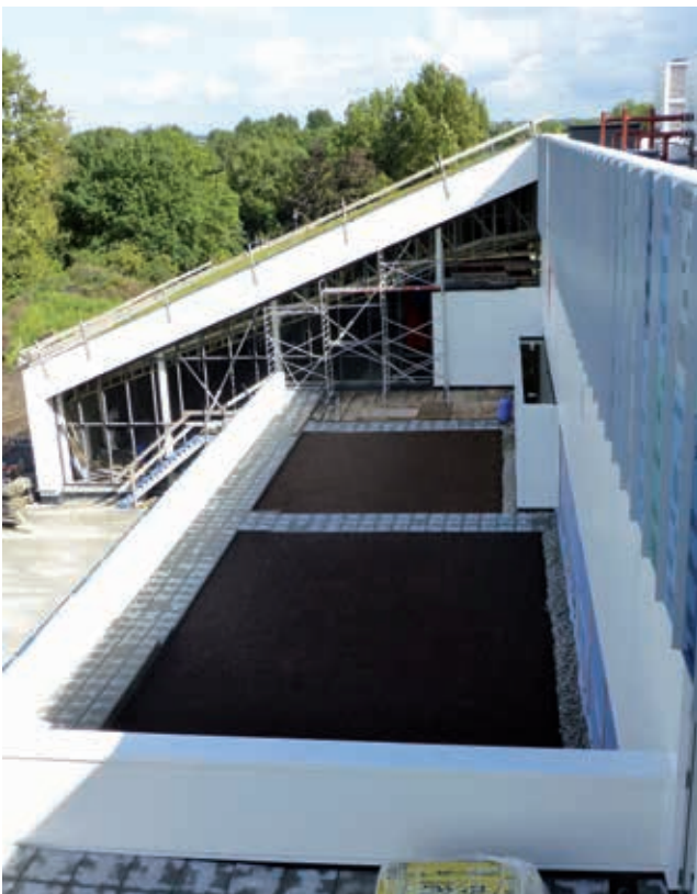
Dak 6 is ook een groendak, maar dan met een grindkoffer langs de gevel en een tegelpad langs de borstwering. Aan het einde tegen de schuine gevel ligt een terras.
