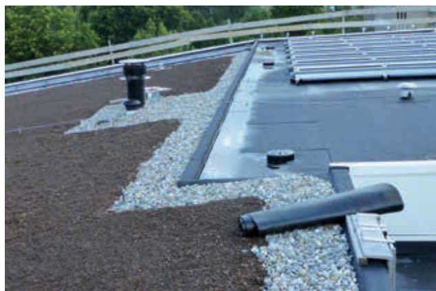
De aansluiting van dak 2 (rechts) op dak 3a (links) is uitgevoerd met een grindkoffer.
