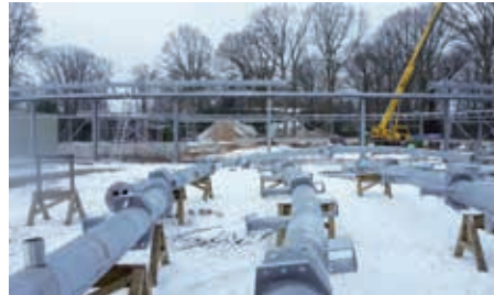
De trek balk en de hoofdliggers van de staalconstructie zijn opgebouwd uit geprefabriceerde segmenten, waaraan flensplaten, consoles en buisstukken al zijn aangelast.
