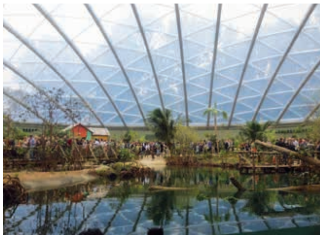
Beeld van onder de overkapping. De luchtkussens zorgen al voor een diffuse lichtinval. (Foto: Burgers' Zoo)
