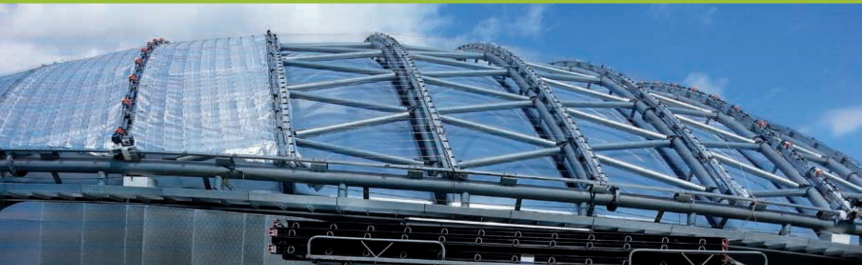
De zonwering is opgedeeld in secties die open- en dichtschuiven tussen twee hoofdliggers en bevestigd zijn aan een hulpconstructie daarop. (Foto: SchermNed)
