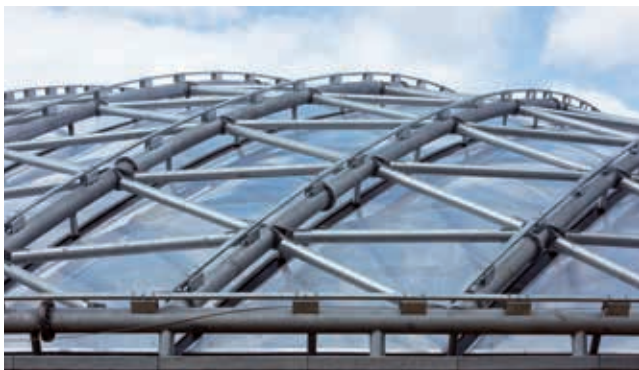
Detailopname van de dakconstructie met de hoofdbuizen, de schoorbuizen en de luchtkussens, vastgezet aan de hulpconstructie onder de hoofdliggers. Daar bovenop is de hulpconstructie voor de zonwering te zien. (Foto: Burgers' Zoo)
