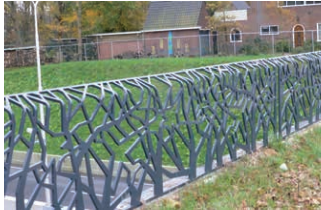
Op de betonnen opstaande randen aan beide uiteinden van het tunneldek is een figuratief hekwerk geplaatst
