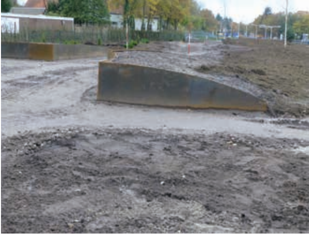
Om de glooiende grondslag bij wandelpaden en dergelijke op hun plaats te houden, zijn keerwandjes van cortenstaal gebruikt
