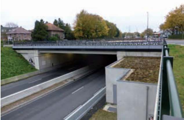
Achter het hekwerk boven op de oostelijke tunnelinrit van de verdiepte N237 begint het landschapspark. Het ligt voor de bomerrij aan de linkerkant
