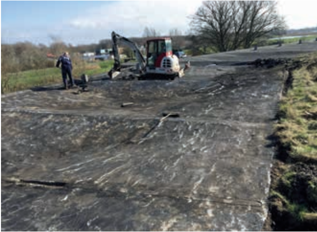
De oude mastiek bedekking is met behulp van machines gesloopt. Hier zijn de trechtervormige dakvlakken goed te zien
