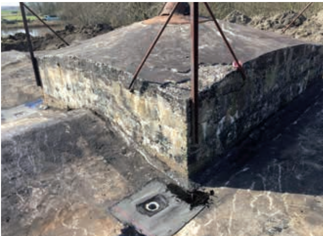
Na de mechanische sloop van de oude dakbedekking moest het betonoppervlak gerepareerd worden
