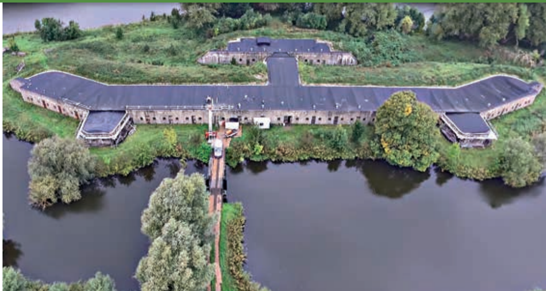
Overzichtsfoto van het fort met vooraan het hoofdgebouw, de twee kazematten, de paterne (verbindingsgang), het frontgebouw en links onder de toegangsbrug
