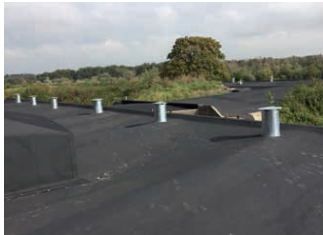
De nieuwe zelfklevende EPDM dakbedekking en de nieuwe ontluchtingskappen zijn aangebracht
